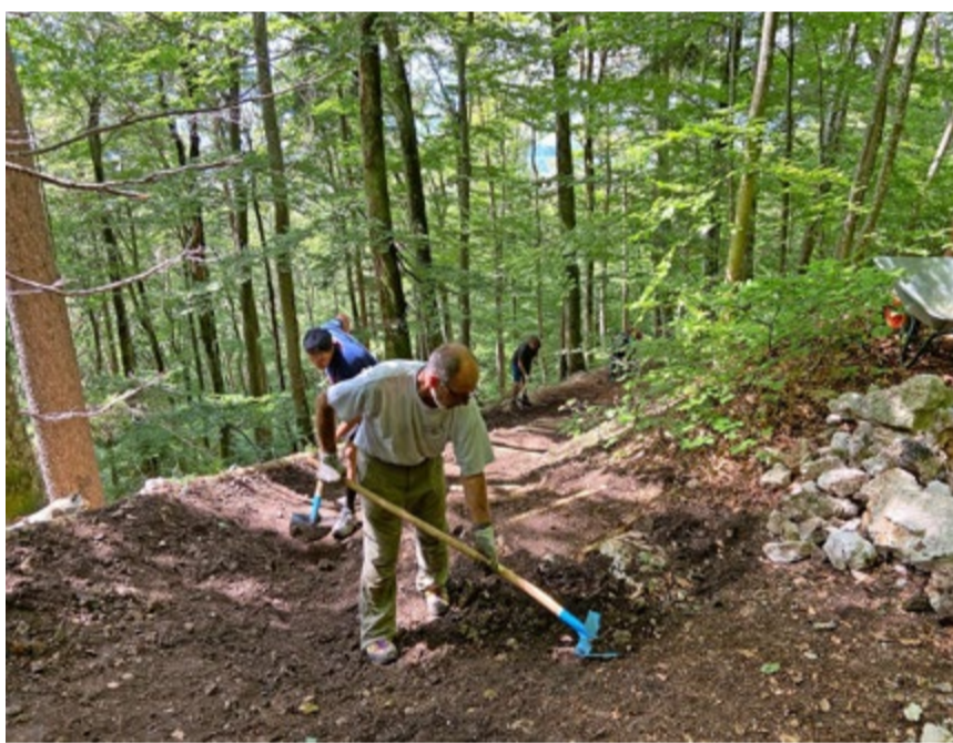
Instandstellungsarbeiten im unteren Stigelos.
